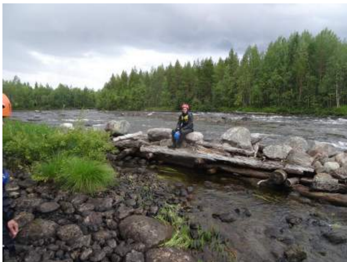
Фото 141. Остатки ряжевой стенки в пороге Кривой.
