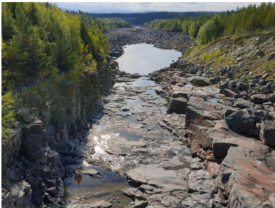
Фото 2. Отводящий канал, прорубленный в скале.
