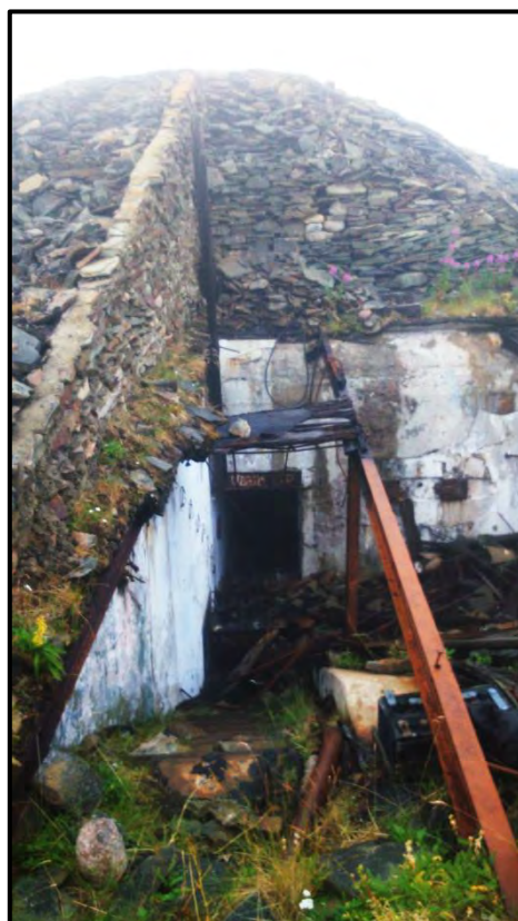
Боевая рубка береговой батареи для управления артиллерийским огнем. Бетонное КП.
