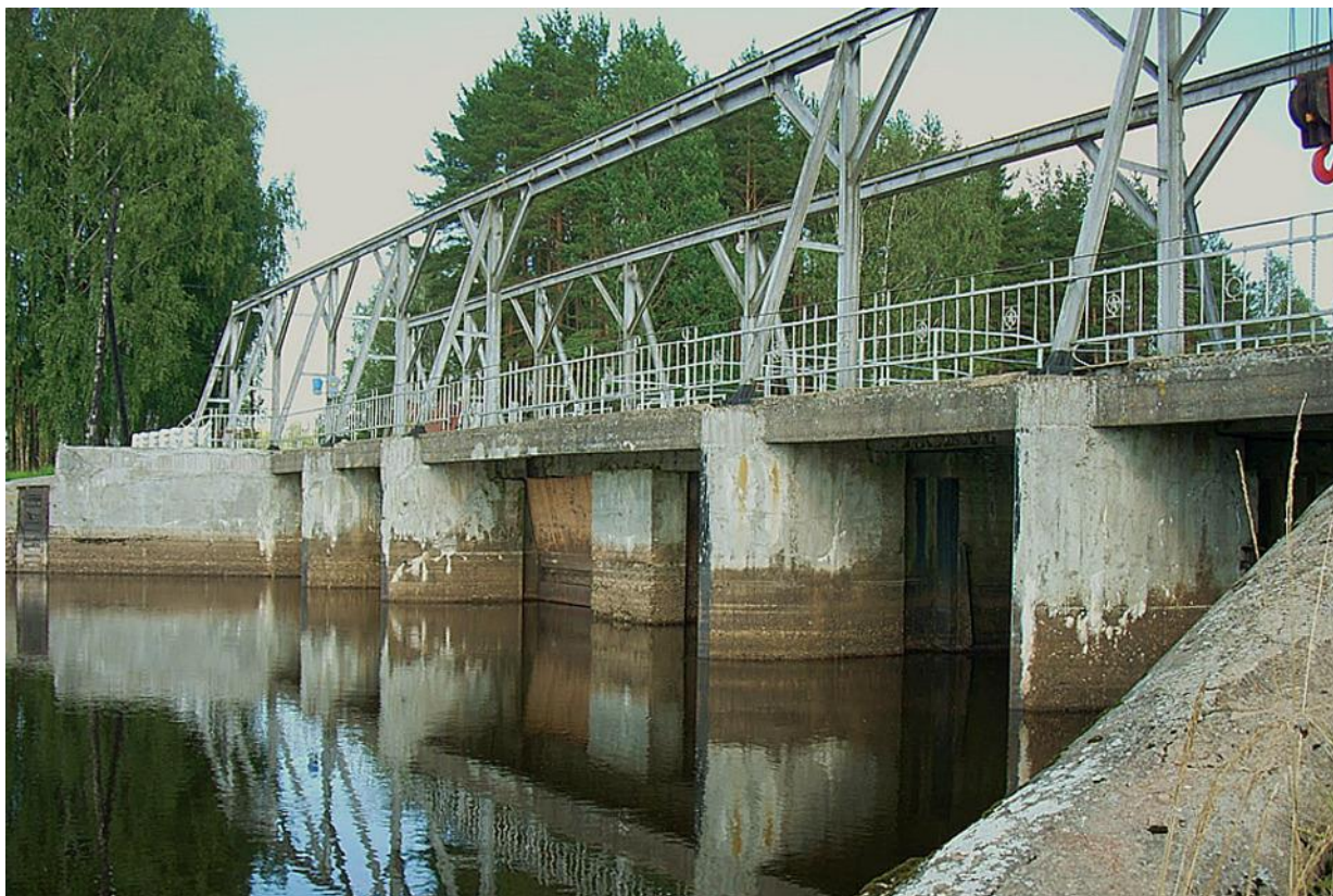
Фото 22. Непосредственно сам бейшлот. Вид с левого берега верхнего бьефа.
