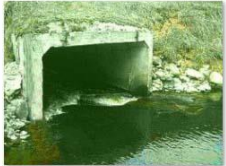
0020-мост у Марково
