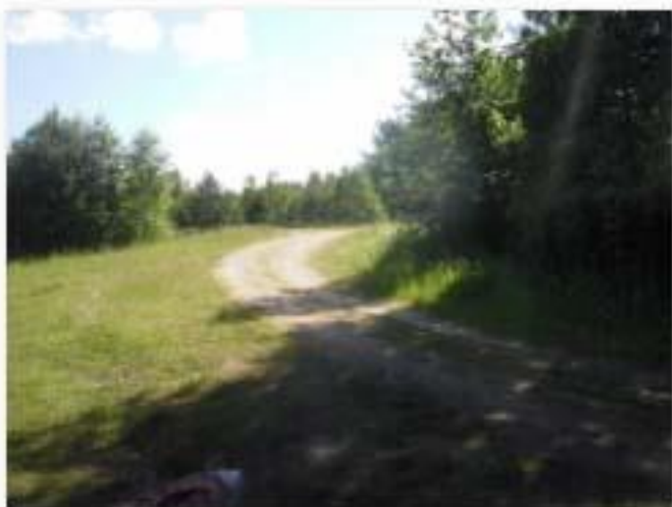
0035-пути обноса плотины
