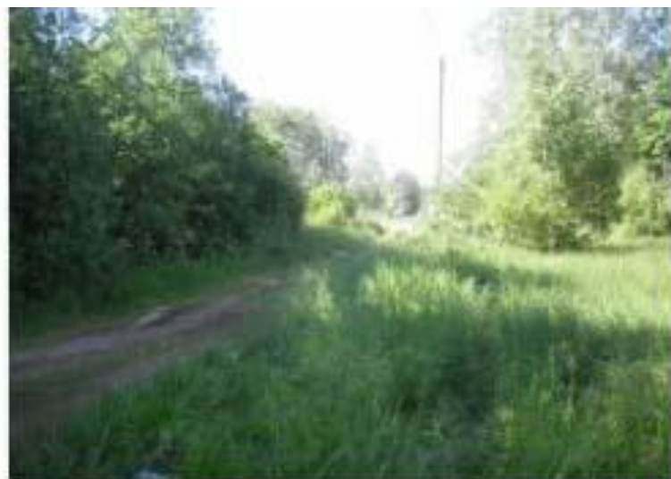
0034-пути обноса плотины
