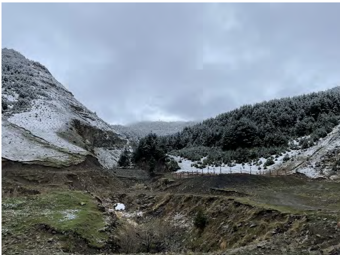
Фото 4.5. Водозаборный узел за ограждением
