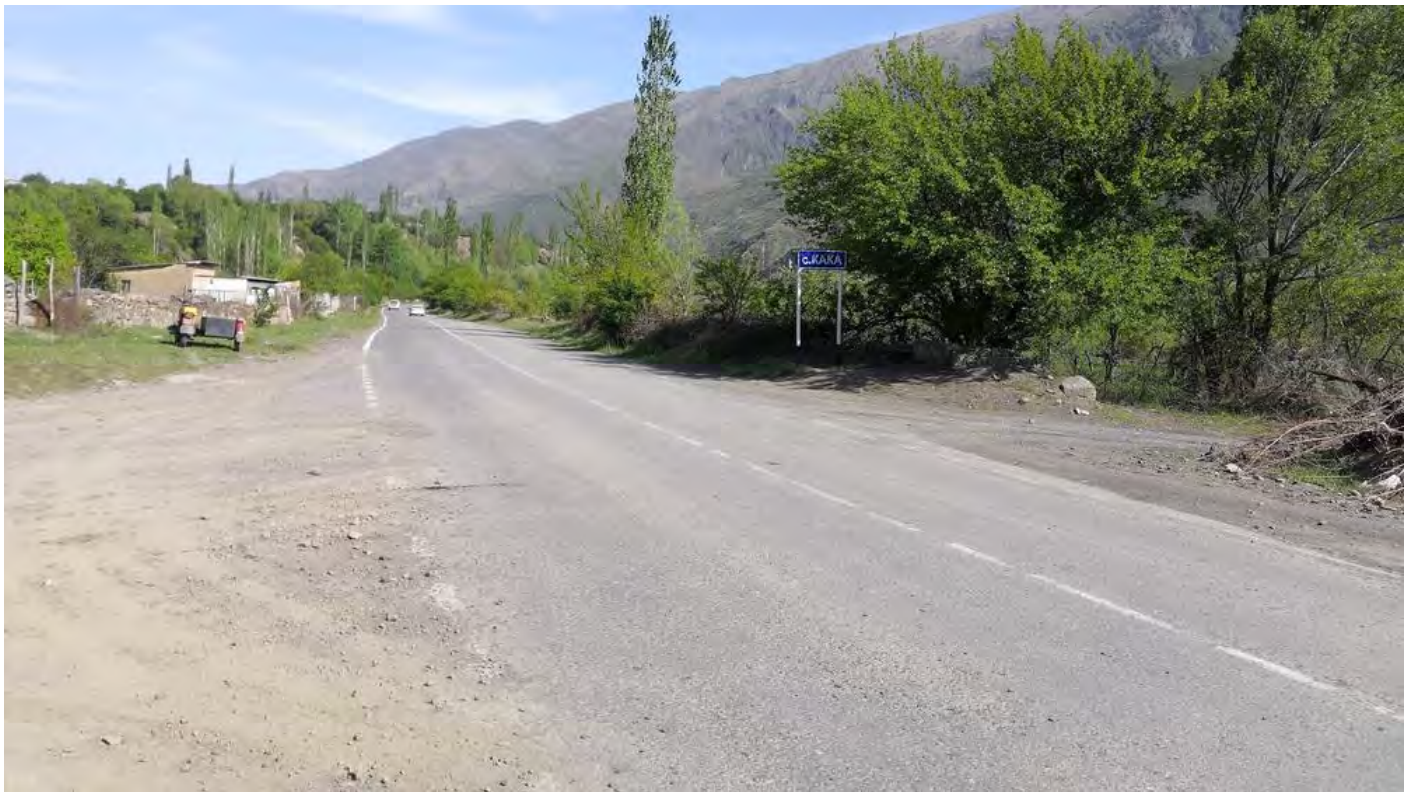
Фото 6.17 Вход в село Кака
